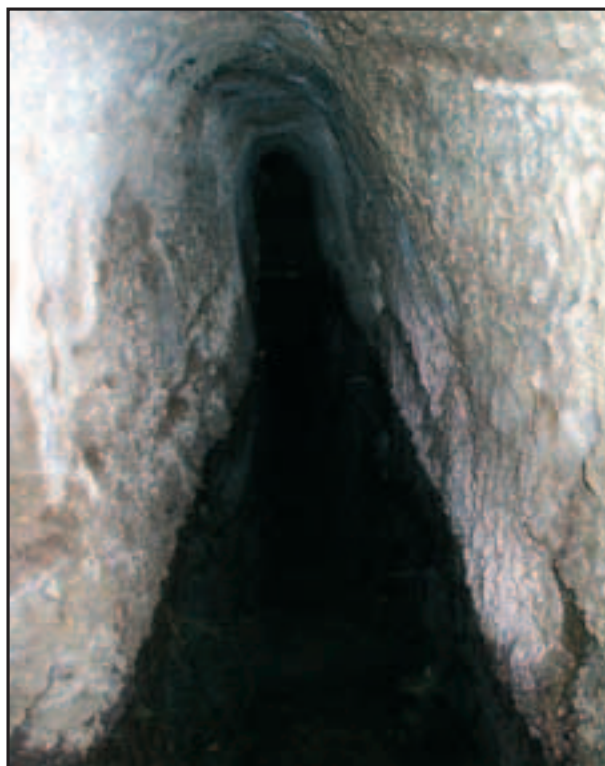
Fig. 9 - Cunicolo zona Procoietto.
