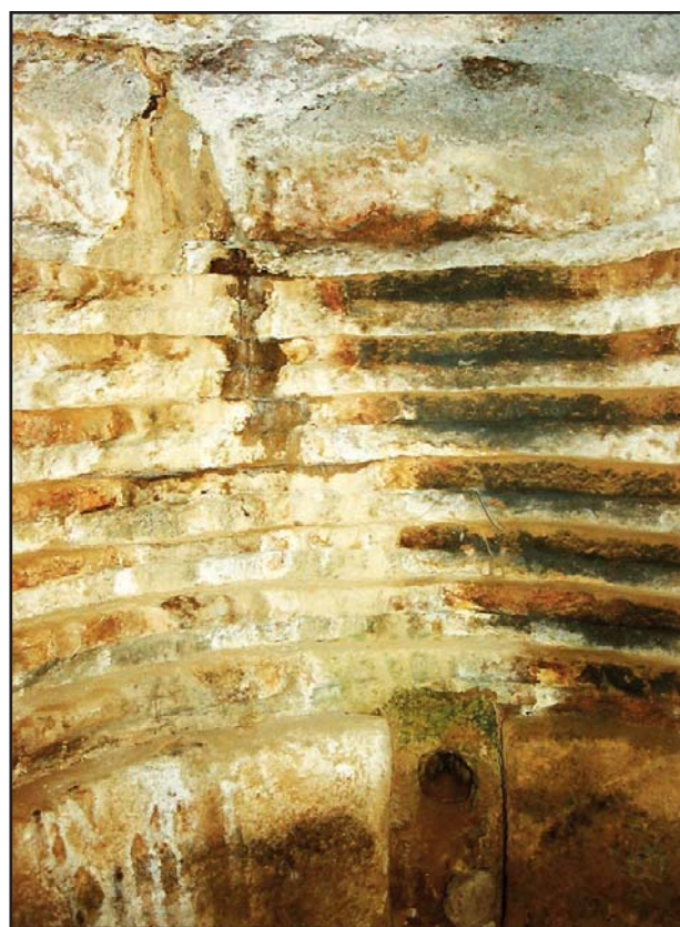
2. Scanalature all'interno del pozzo.
