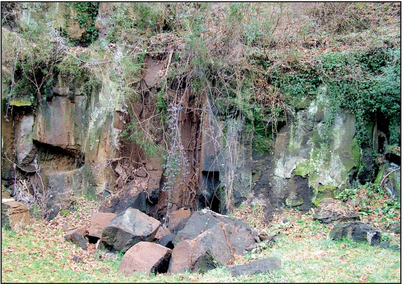
Norchia: uno dei numerosi crolli che fanno gridare allo scandalo.
