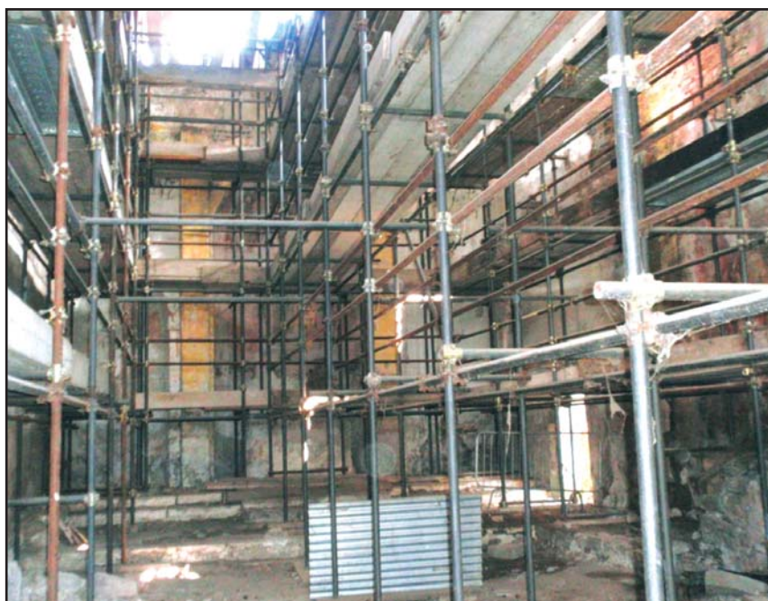
Chiesa di Santa Maria in Forcassi a Vetralla: impalcatura posizionata all'interno da un decennio circa.
